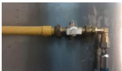
Pour utiliser la gazinière ou le four, il faut d'abord... ouvrir le gaz. L'arrivée de gaz se gère grâce à un robinet blanc sur le tuyau en cuivre à gauche de la gazinière. **Sur la photo, c'est ouvert !** Le tourner dans l'autre position (molette perpendiculaire au tuyau) pour le fermer !
