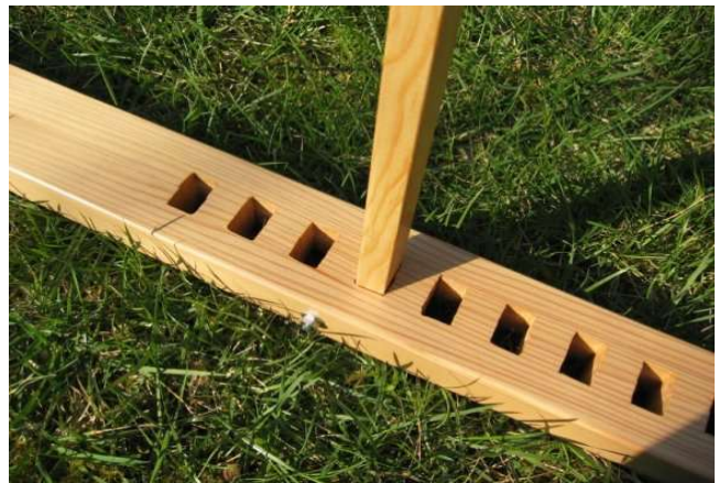
Le socle en deux parties assemblées, on aperçoit une vis.
