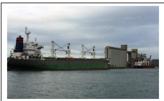
Silos de l'île Elouis au Port de Rouen
