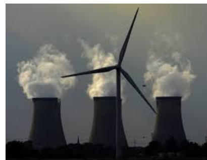
Eolienne et sa « roue de secours »
