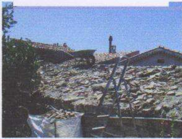
Pendant les travaux ...
