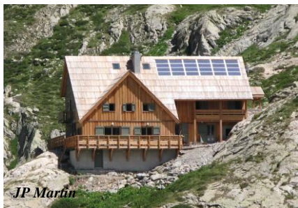
Panneaux photovoltaïques au refuge de Nice
