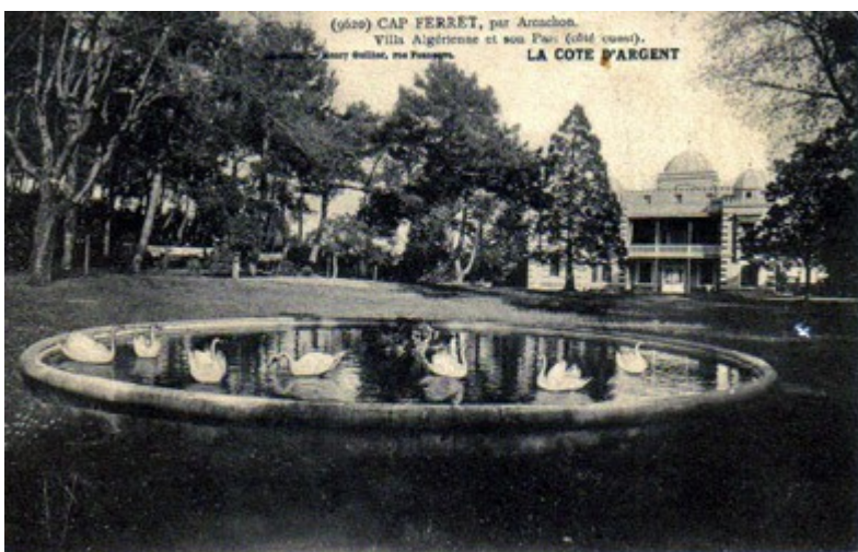
L'arrière de la Villa. , vue du parc, côté Ouest.
