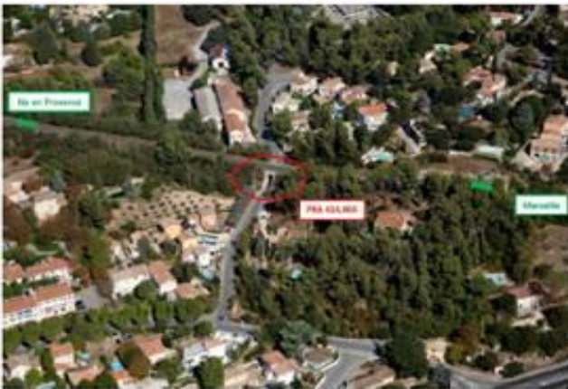
Vue du pont-voûte actuel sur le chemin des Frères Gris
