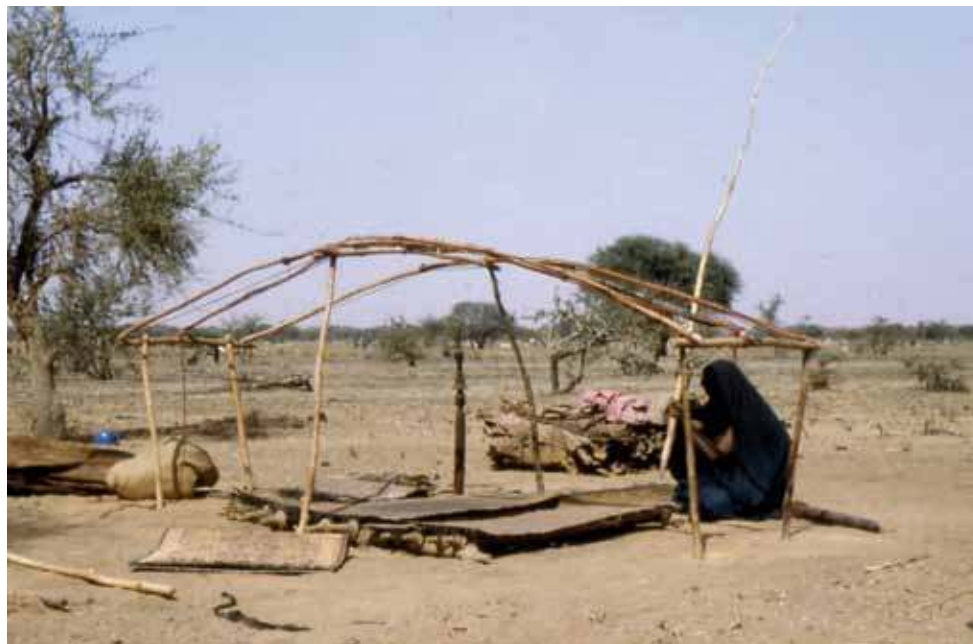
Construction de la tente en peau, Arabanda, 1984. (Fig. 3)
